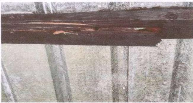
foto 3: Soporte de lámina de madera quebrada, modulo 1
